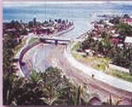
Flood Control System sa Ormoc City
